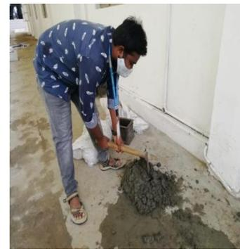
**FIG-2.6. MIXING OF CONCRETE**
